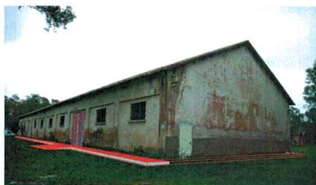
Simulazione realizzazione marciapiede e rampa carrabile
